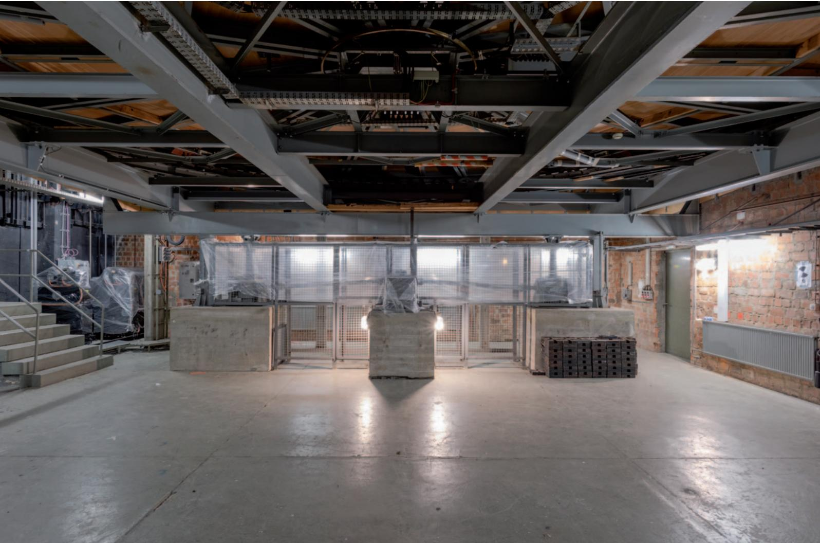
96 Unterbühne mit Drehscheibe und Hubmaschinerie für die bis zu 5,7 Prozent schrägstellbare Bühnenfläche, 2023
