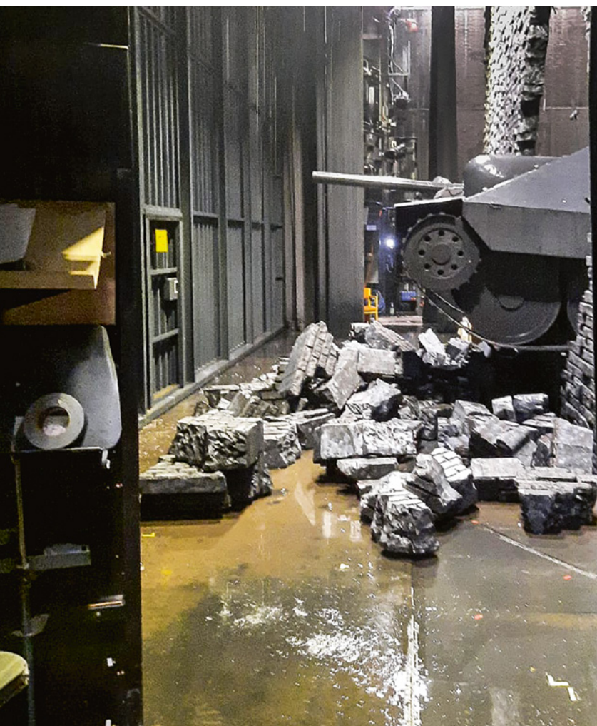
Die Wasserschäden an den Theatern Görlitz (oben und unten) und Hof (Mitte) im Jahr 2022
